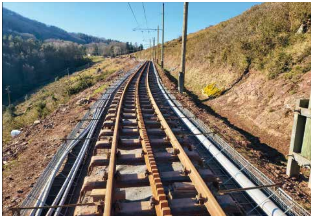
La voie neuve, avec traverses métalliques en auge Tracknet, du chemin de fer de la Rhune (2 février 2023).
